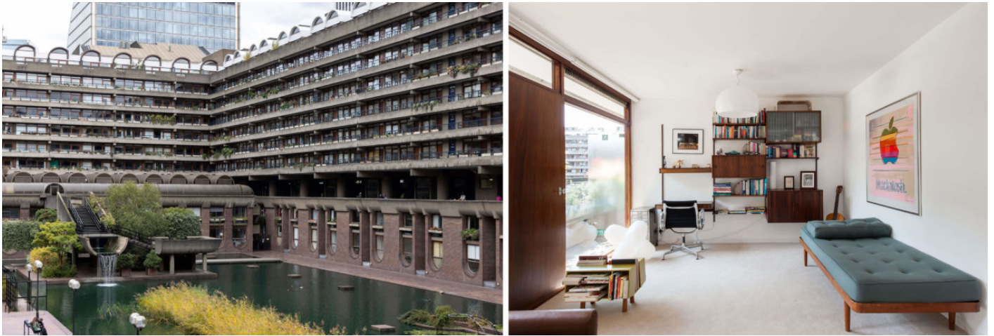
Vue extérieure de « Andrewes House » et vue intérieure de « Andrewes House », Barbican, Londres ⓘ
