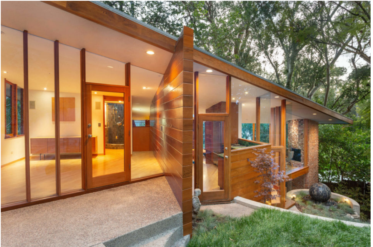
Vue extérieure de « The Tyler House » de John Lautner (1953) ⓘ
