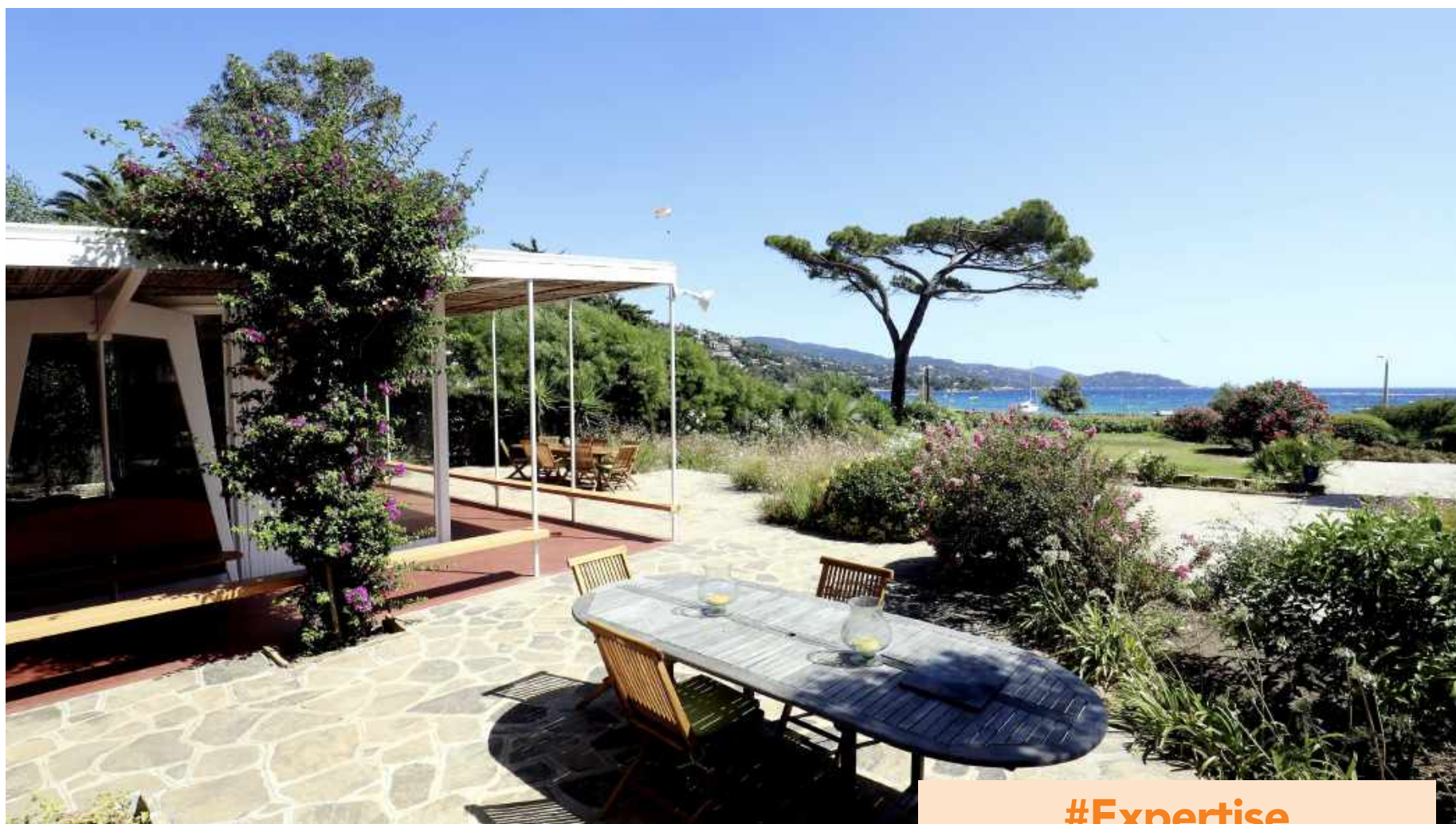
La résidence secondaire de la famille Dollander a été construite entre 1949 et 1951.
